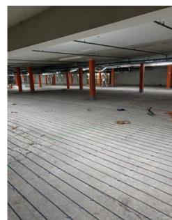
Nachhaltiger, zerstörungsfreier Schutz der bestehenden Tragstruktur vor Korrosion durch kathodischen Korrosionsschutz.
