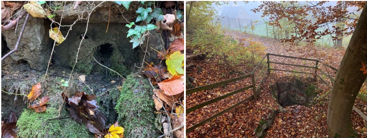
Abbildung 2: Quellaustritt im Wald (links) und Blick auf den Einlauf zur langen Eindolung (rechts)
